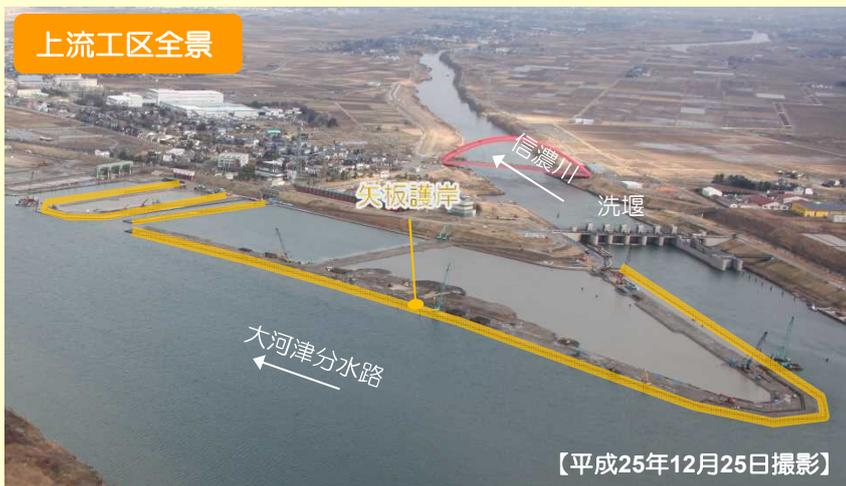
上流工区の旧可動堰右岸上流部では、護岸工事を進めています。護岸本体となる鋼矢板の打ち込みが2月上旬で完了し、現在は、根固となる粗朶沈床・異形ブロックの設置、天端保護ブロックの設置工事を実施中です。
