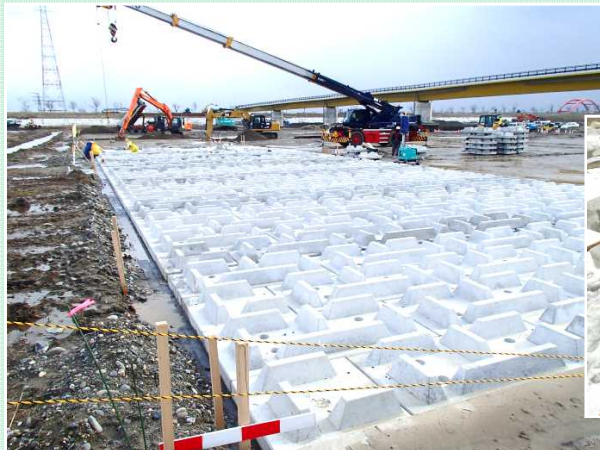
施工状況 (H26.1.16撮影)
