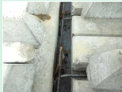
ブロックを連結している鉄筋
