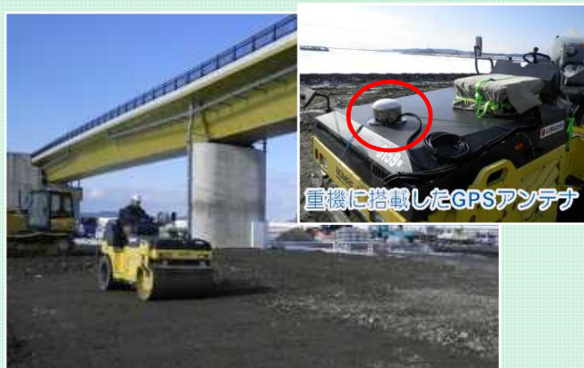
ローラーによる転圧作業
