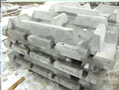
設置しているブロック
