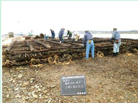
現場での製作状況
