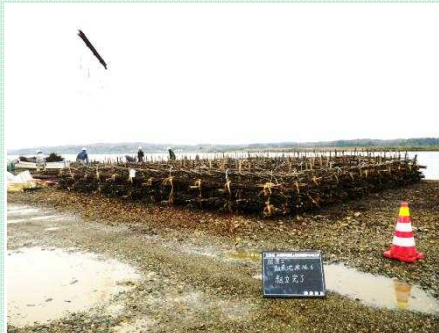
製作が完了した粗朶沈床（縦横10m）
