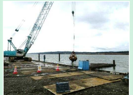
クレーンで沈石を投入して水中に設置
