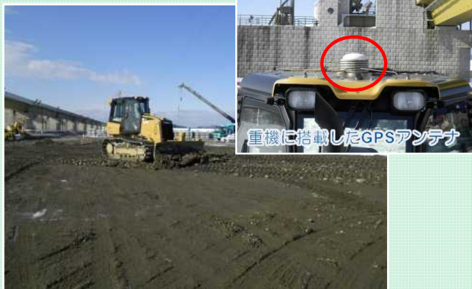
ブルドーザーによる土砂の敷均し作業
