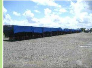
可動堰上流の左岸高水敷で、護岸の根固ブロック（1個の重さ4t）を製作しています。
