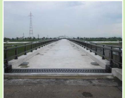
橋面の完成状況。今後、アスファルトによる舗装工事を行います。
