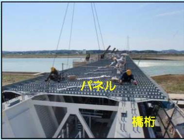
鋼製のパネルを橋桁の上にクレーンで設置します。
