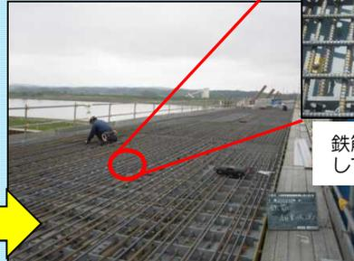
設置したパネル上に鉄筋を組み立てます。
