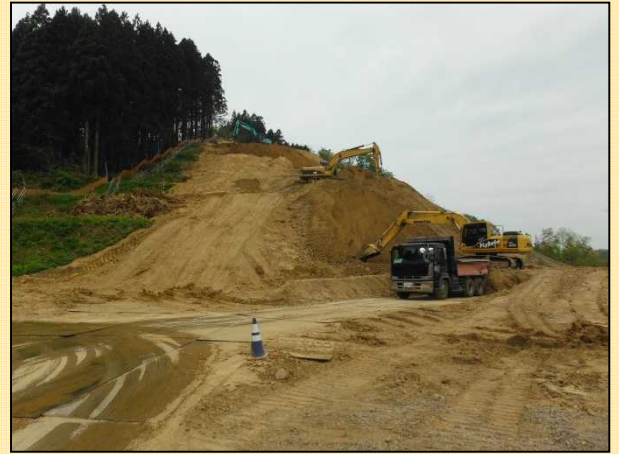
渡部地区 土砂採取状況
