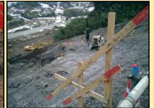
丁張りの設置例
