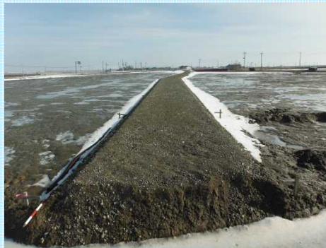
新堀地区 道路整備
