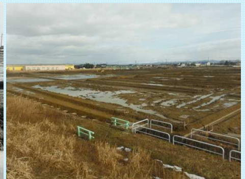
中条新田地区 水田復旧中
