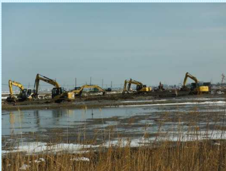
新堀地区 整地作業
