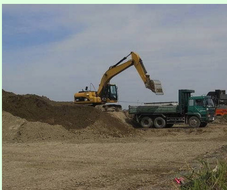
新堀地区での土砂積込状況
