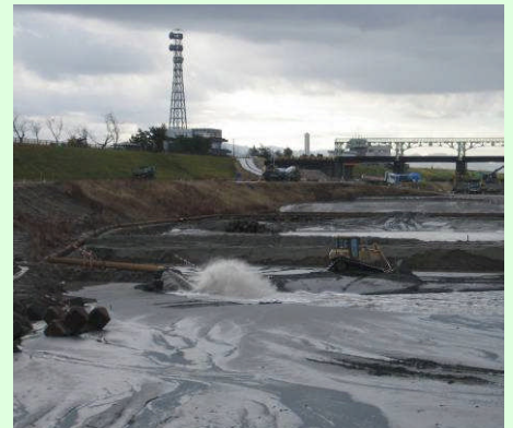
川底の浚渫土による 造成状況
