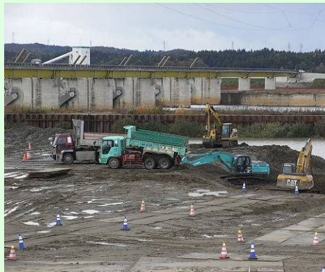
発生土受け入れによる 造成状況
