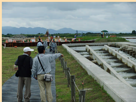
新可動堰の魚道を間近でご覧いただきました。
