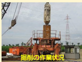
掘削しながら地盤に押し込んでいくパイプ工法
