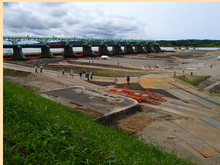
新可動堰の通水前まで水が流れていた川底に入場いただきました。
