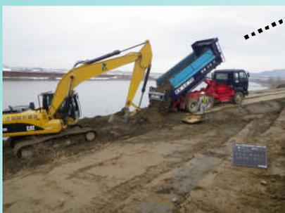
(写真上・左) 分水路右岸側から土砂を盛り、トラックも走れる運搬路も兼ねた締切(①)の造成を始めています。
