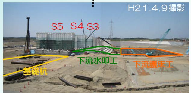
平成21年の夏には5本目の堰柱が完成し、新堰中央部の水叩・護床部分も整備されました
