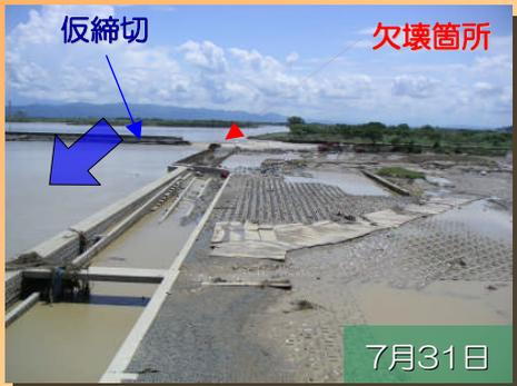
仮締切が欠壊し、現場内へ河川水が流れ込んでいる状態です。
