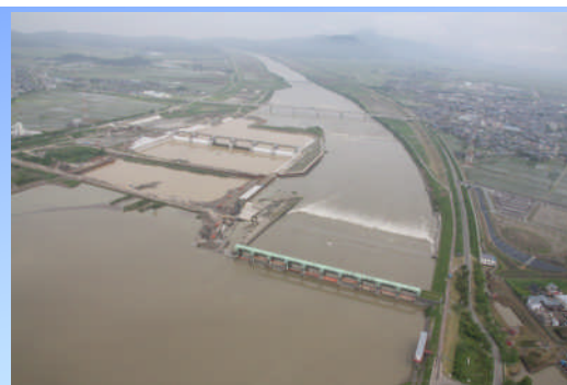
工事現場内の浸水状況
