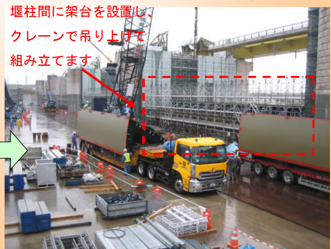
ラジアルゲートの仕組み
