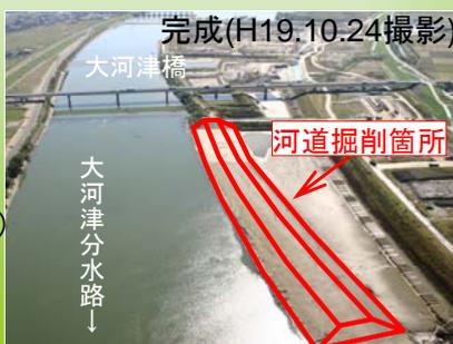
掘削を行った箇所は、可動堰完成後に新しく河道となります。現在の高水敷を延長約360m、幅約40m、高さ約5m掘下げました。
