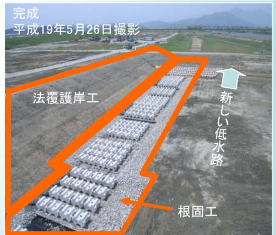
護岸工事では、植物が生えやすいようにコンクリートブロックの上を土砂で覆いました。また護岸の基礎部には、洗堀を防いだり魚や昆虫が棲めるように、コンクリートブロックの下に、雑木から伐採した木の枝を用いて造る木工沈床や粗朶沈床を敷いています(上の3枚が施工中の写真です)。右が完成後の写真です。
