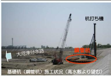
4月から、いよいよ堰本体を支えるた めの基礎となる杭(鋼管杭)の打ち込み が始まりました。杭打ち機の手前に見え るもの(茶色)が鋼管杭で直径約1m、現 在の地盤から地中に深いところで7m以 上も打ち込んでいきます。
