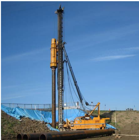
写真左 基礎杭施工状況(平成18年12月撮影)
