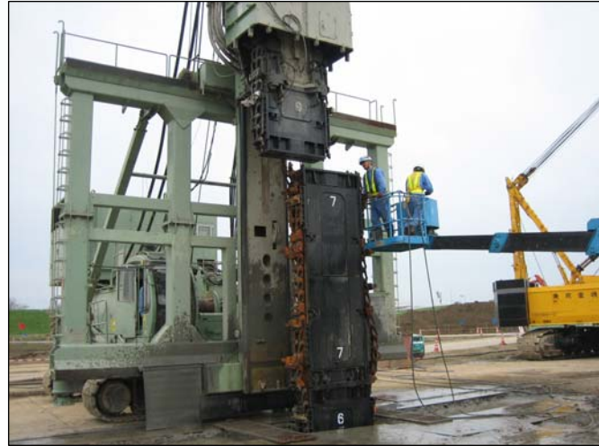
分割されたカッターポストの接続状況 (横にいる人間と大きさを比べてみてください)
