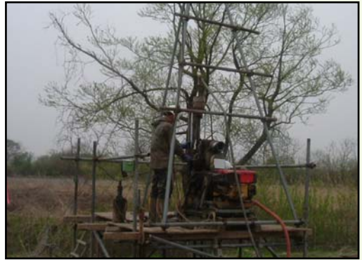
ボーリング調査実施状況
