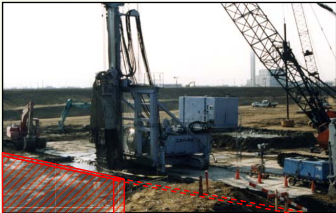
大河津洗堰改築工事時の TRD工法実施状況
