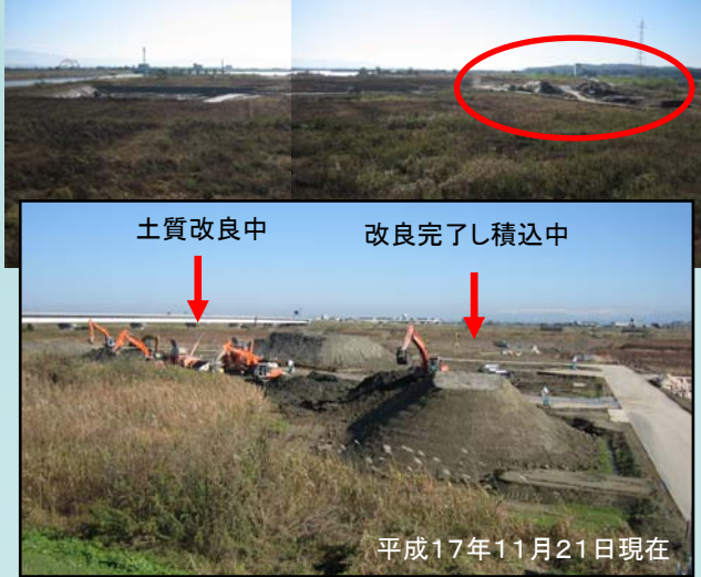
大河津橋より見た工事現場状況(大河津橋上流側)
