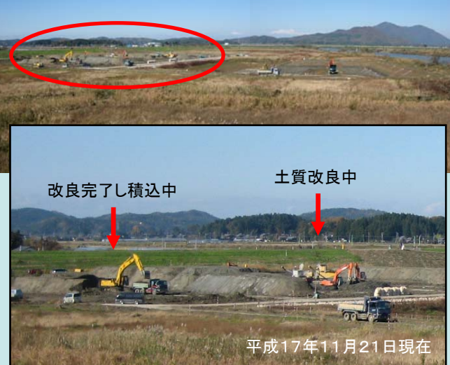
大河津橋より見た工事現場状況(大河津橋下流側)
