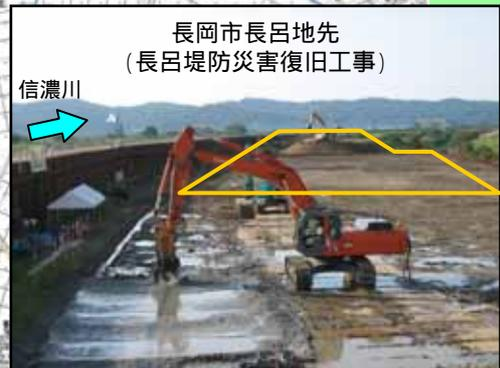
堤防盛土に先だって、堤防の基礎になる部分の地盤改良を行っています。この上に、河道掘削工事現場の土砂を盛土し堤防をつくっていきます。
