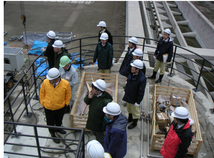
可動堰本体工事現場視察状況
