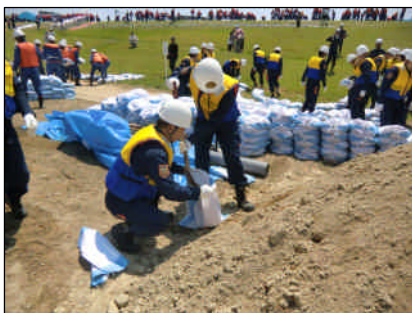
堤防の漏水を防ぐ月輪工法
