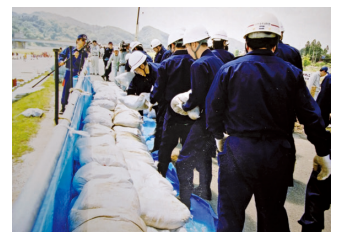
改良積み土のう工
