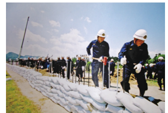
積み土のう工
