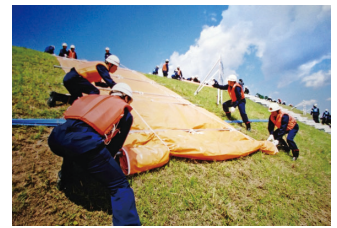
シート張り工
