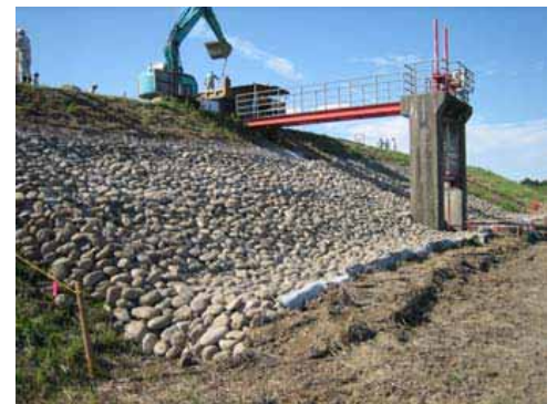
被災した堤防護岸の前面に「じゃかご」を設置し、堤防としての機能を回復しました。
