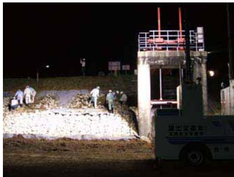
24時間体制で「じゃかご」の設置を行いました。写真は照明車により照らされた現場の様子。
