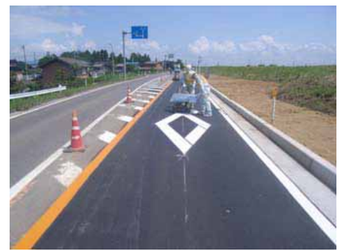
27日までの10日間で、切返し盛土・アスファルト舗装を実施し、堤防機能と道路機能を回復しました。写真は完成目前の区画線を設置しているところです。
