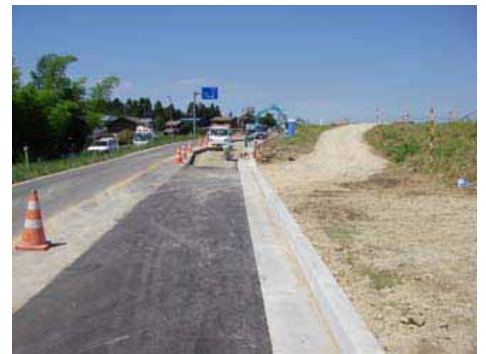
切返し盛土後、上面の路盤・アスファルト舗装を実施しています。すでに堤防としての機能は回復しています。
