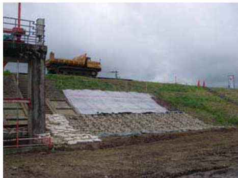
被災した堤防護岸の前面に、「じゃかご」を設置しています。引き続き上段部を施工します。
