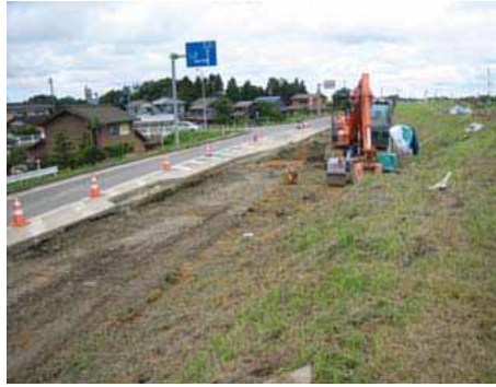
亀裂が入った箇所を切返し盛土で復旧している様子。
