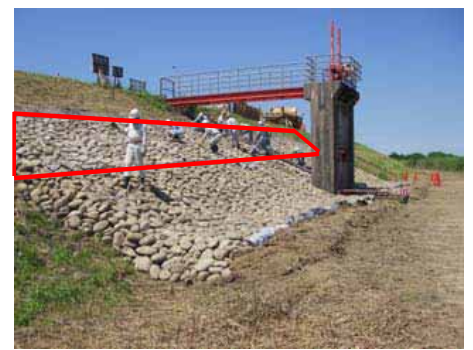
「じゃかご」を被災した堤防護岸の上段部にも設置しました。これで、堤防としての機能を回復しました。
