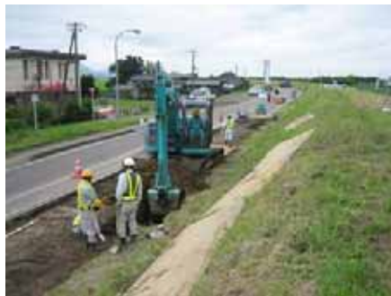
掘削後、埋戻し、締固めを修正しているところです。
