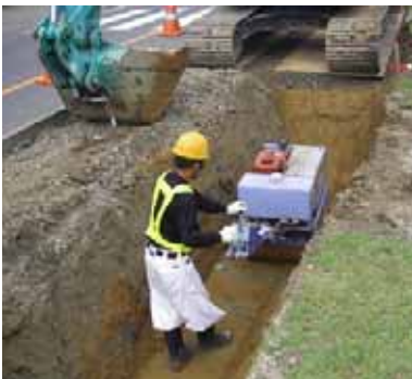
亀裂が入ったところまで掘削が完了し、再度念入りに締固めを行っているところです。
