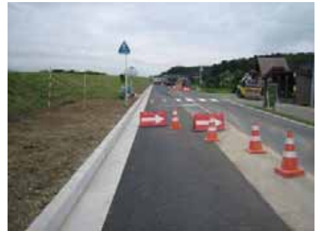
100m区間で舗装が完了しました。
