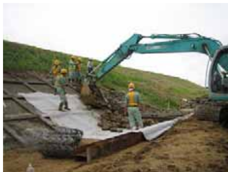
敷き均した後、じゃかご工を行います。じゃかご工は、鉄製の網の中に石を詰める応急復旧工法です。
