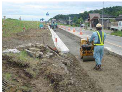
掘削後、埋戻し、路盤を整形しているところです。
