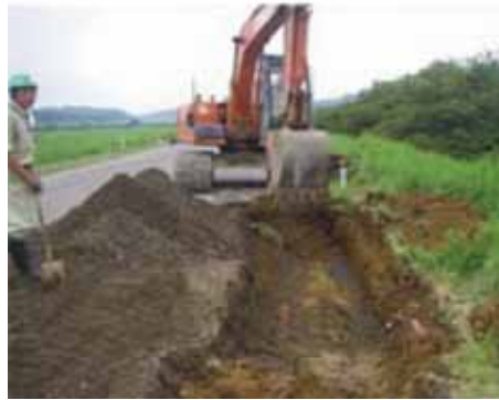
亀裂の部分を含め掘削しているところです。
