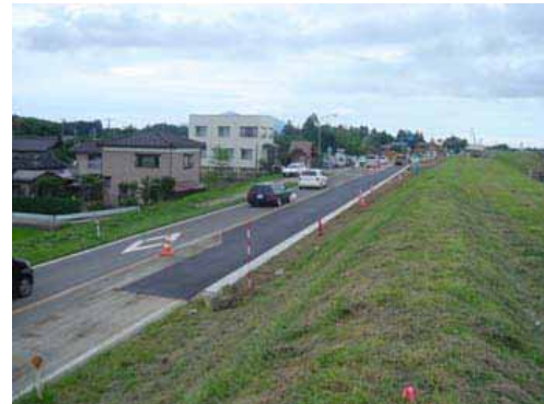
100m区間で舗装が完了しました。
