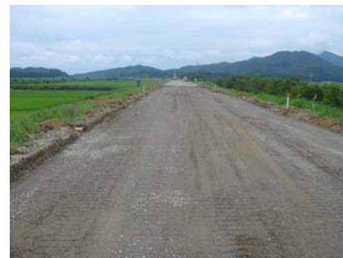
掘削後、盛土を完了したところです。
