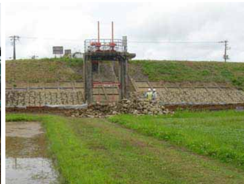
堤防護岸の損傷部へのじゃかご設置を完了しました。
