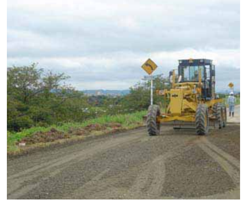
掘削後、埋戻し、路盤を整正しているところです。
