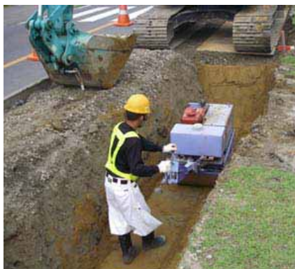
亀裂が入ったところまで掘削が完了し、再度念入りに締め固めを行っているところです。
