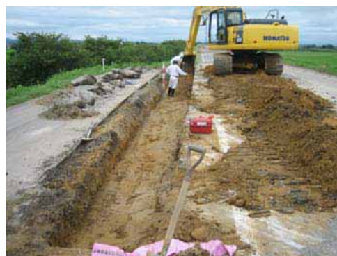
石灰で、亀裂を確認し、掘削しているところです。
