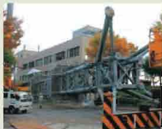
吊り下ろした鉄塔
