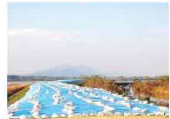
11月6日 緊急復旧完了
