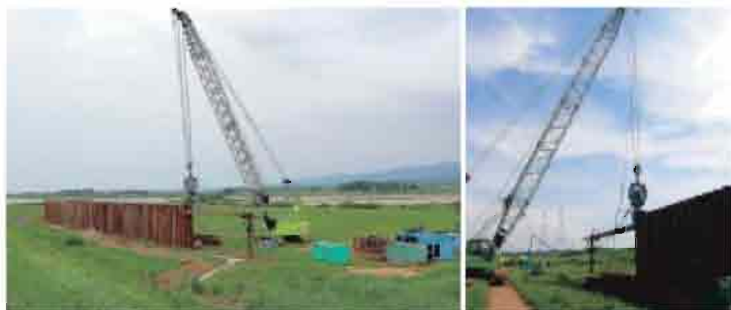
仮締め切り鋼矢板打ち込み
