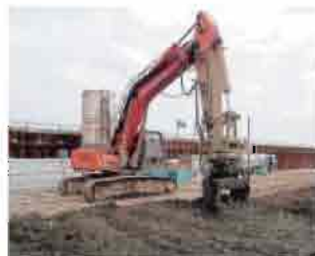
浅層地盤の改良（与板町本与板地先）
