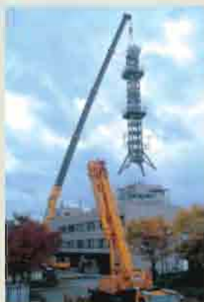
鉄塔吊り上げ状況
