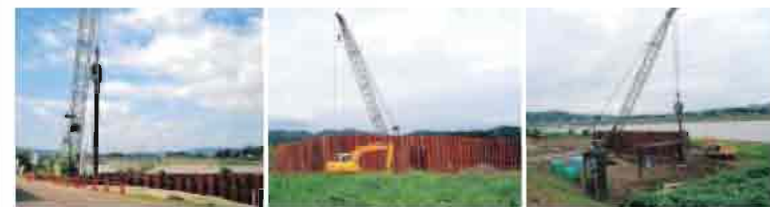
仮締め切り鋼矢板打ち込み
