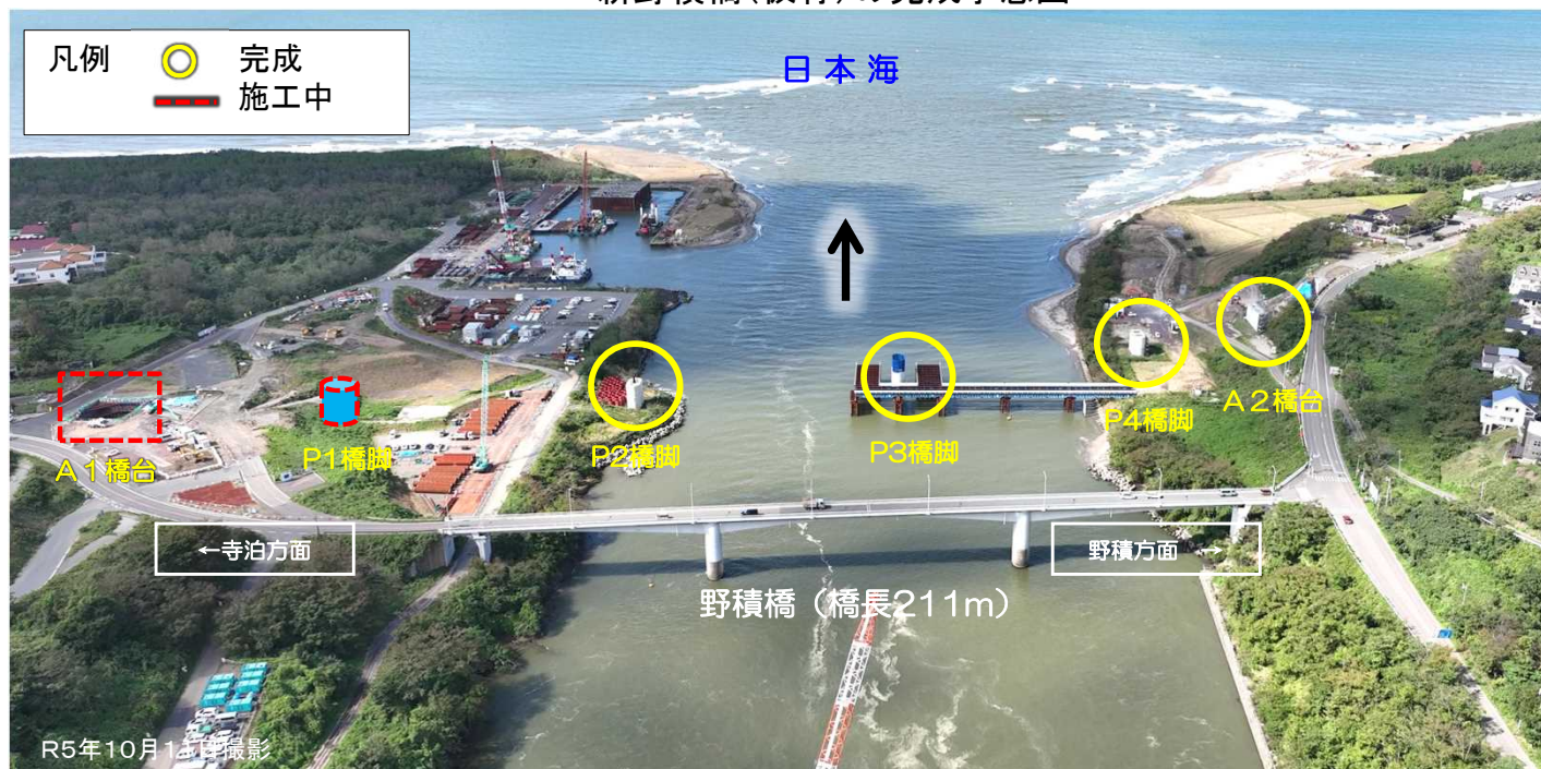
野積橋架替工事の全景写真 (上流方面から下流方面を望む)
