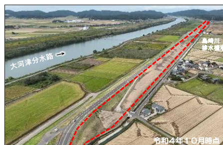
右岸堤防浸透対策
