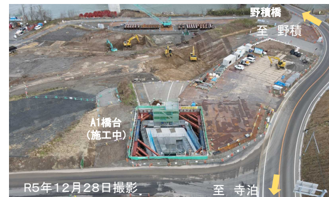
A 1 橋台 施工状況
