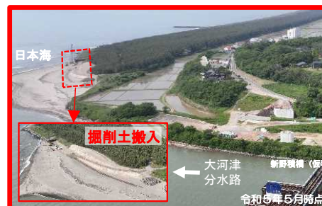
野積海岸部侵食対策
