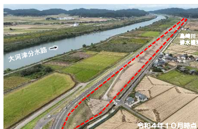
右岸堤防浸透対策
