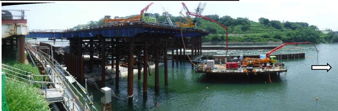
作業構台を利用したコンクリート打設（通常時）
