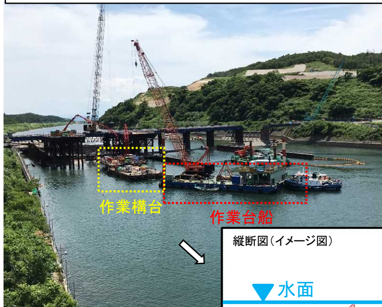
船舶作業と作業構台から並行して作業（通常時）
