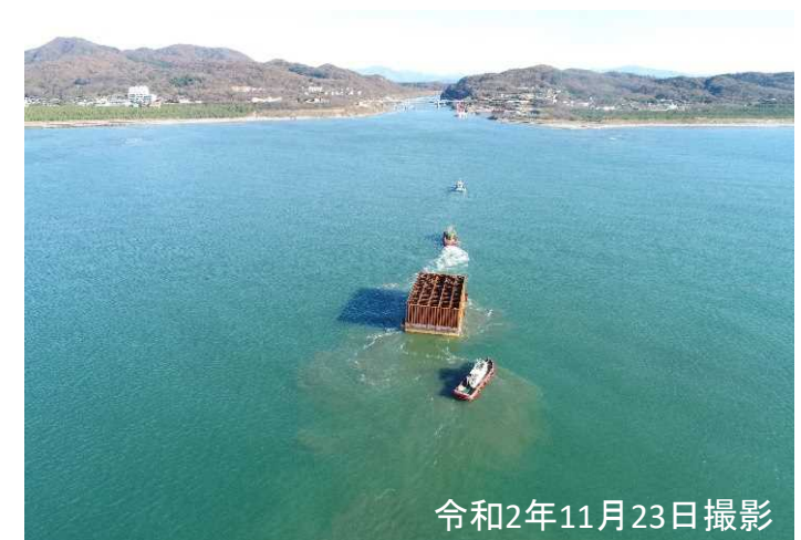
鋼殻ケーソンの海上曳航状況
