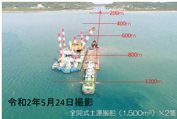
航路浚渫の実施状況
