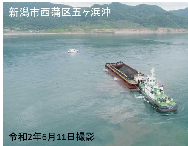
五ヶ浜沖での浚渫土砂投入状況
