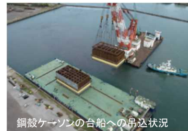
台船への吊込状況
