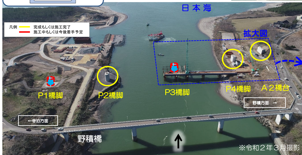
野積橋架替工事の全景写真
