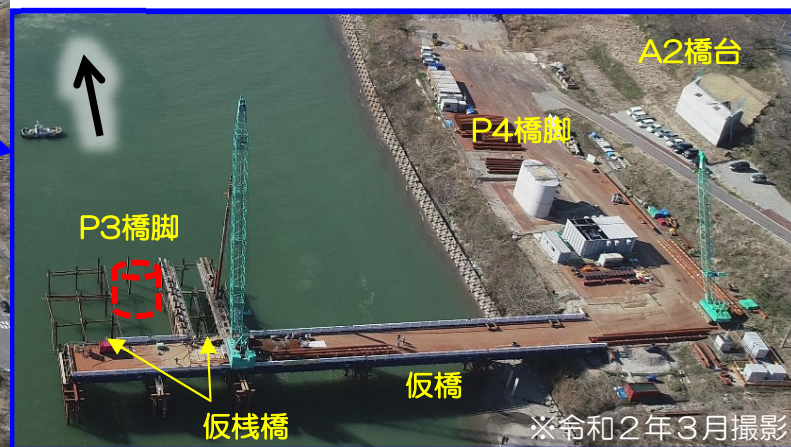
施工が完了した右岸側A2橋台・P4橋脚と、P3橋脚施工に向けて製作している仮栈橋の状況
