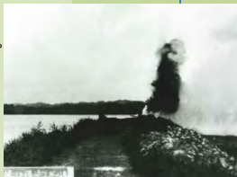
通水のため締切堤防を爆破。
