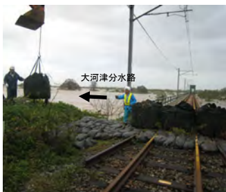
(左岸)土のう積 作業状況(長岡市)
