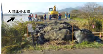
(右岸)土のう積 作業状況(燕市)
