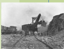
イギリス製の岩盤掘削機スチームナビー。
