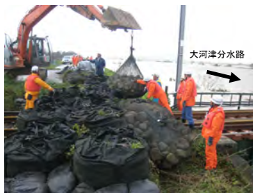
(左岸)土のう積 作業状況(長岡市)
