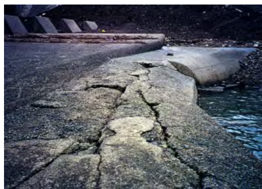
老朽化の著しい第二床固
