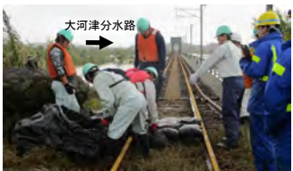
(右岸)土のう積 作業状況(燕市)
