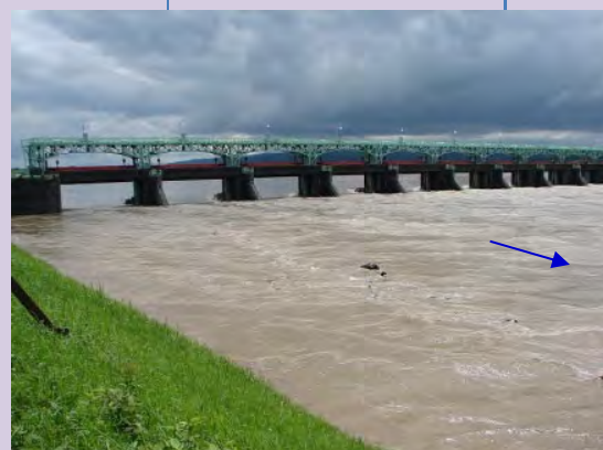
※4 平成18年7月、ゲートを全開にして洪水を流す旧可動堰。人々の暮らしを守り続けてきた一方で、洪水による摩耗・損傷など旧可動堰はダメージを蓄積していきました。
