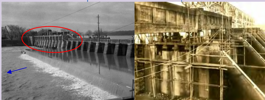
嵩上げ中の洗堰(左)と可動堰(右)。
