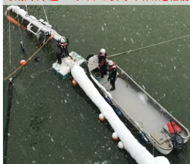
冬期間(水温1℃以下)でも、水中作業を継続
