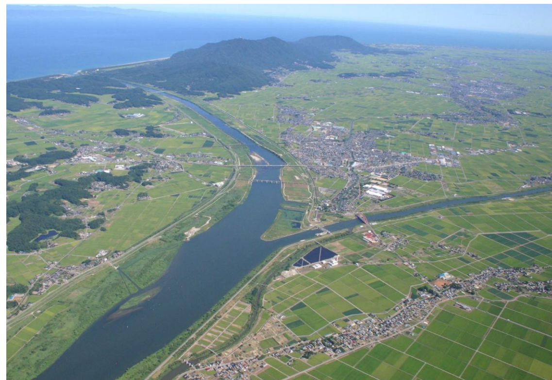
上空から見た大河津分水路
