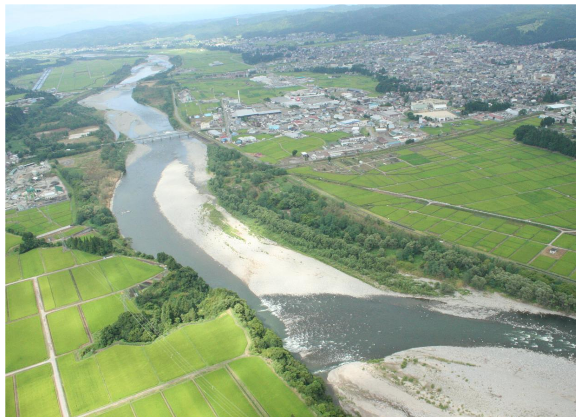
上空から見た信濃川（十日町橋付近）
