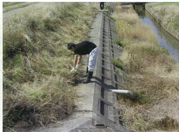
瀬ヶ通樋管先
