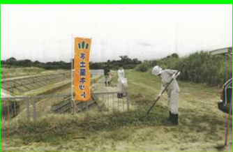
②白根郷土地改良区による各種管及び導水路の除草、不法投棄防止の看板等の設置及び補修、清掃（大島頭首工、赤波橋管 外）
