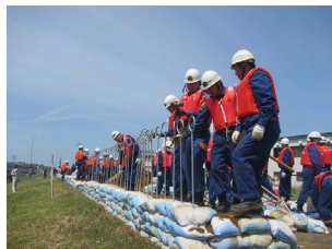
積み土のう工
