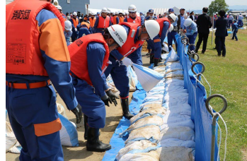
改良積み土のう工
