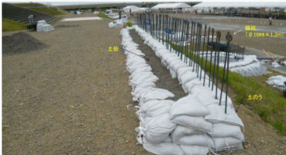
⑤ 積土のう工(10m)
