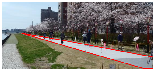
写真2-④-2 天端石張広場の拡大【市】 (萬代橋上流左岸)
