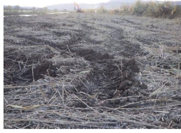
【整備前の地盤状況】
