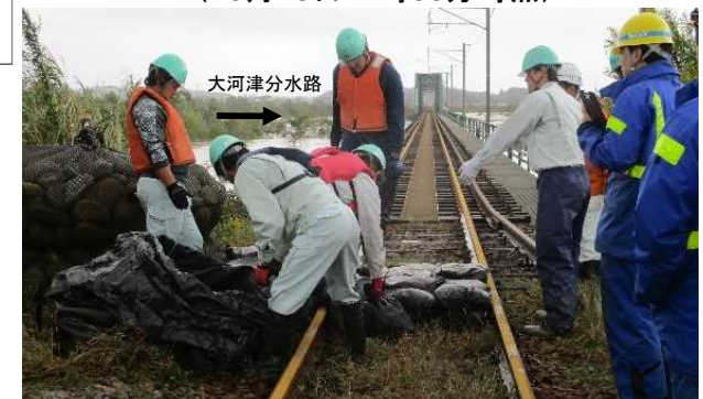
(右岸)土のう積 作業状況(燕市)
