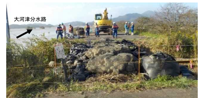
(右岸)土のう積 作業完了(燕市)
