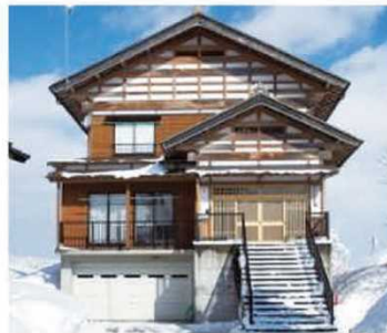
高床式住宅の事例 (新潟県十日町市)
