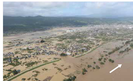
長野市穂保地先の堤防決壊、浸水被害状況
