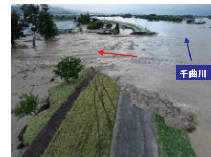
令和元年10月洪水における長野市穂保地区の決壊状況
