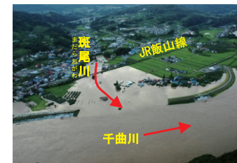
平成18年7月洪水時における中野市替佐地区の浸水状況
