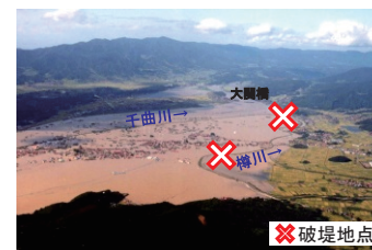
昭和57年9月洪水時における支川樽川の破堤状況
