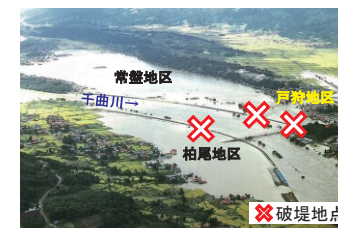
昭和58年9月洪水時における千曲川本川の破堤状況
