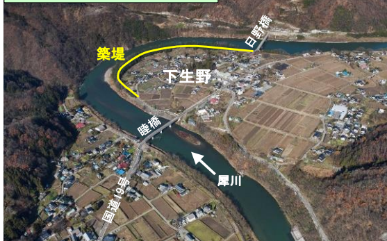
下生野地区堤防整備区間(図3-3)
