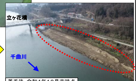
立ヶ花狭窄部 河道掘削実施状況(図3-10)
