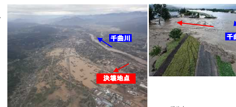
【令和元年(2019年)10月洪水】長野市穂保地先決壊状況
