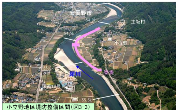
小立野地区堤防整備区間(図3-3)
