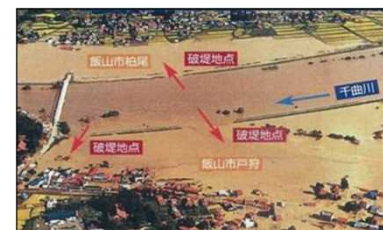
【昭和58年(1983年)9月洪水】飯山市柏尾・戸狩地先本川破堤状況
