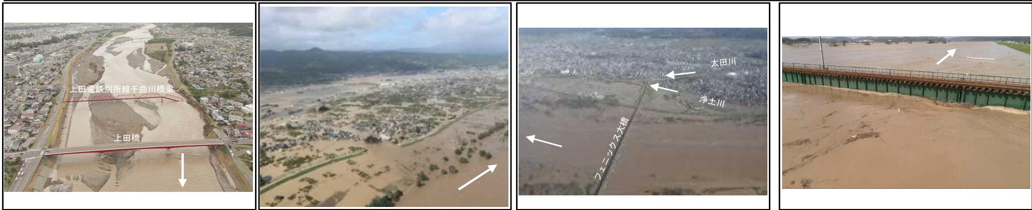
千曲川堤防欠損状況(上田市諏訪形地先) 千曲川堤防決壊状況(長野市穂保地先) 信濃川浸水状況(長岡市今井地先) 大河津分水路増水状況(JR越後線橋梁)
