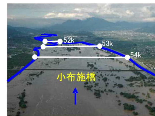
平成18年7月洪水の せき上げ状況
