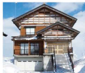
高床式住宅の事例 (新潟県十日町市)
