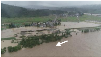
新潟県小千谷市内における浸水被害状況 ※計数については、今後の調査、検討等の結果、変更となる場合がある。
