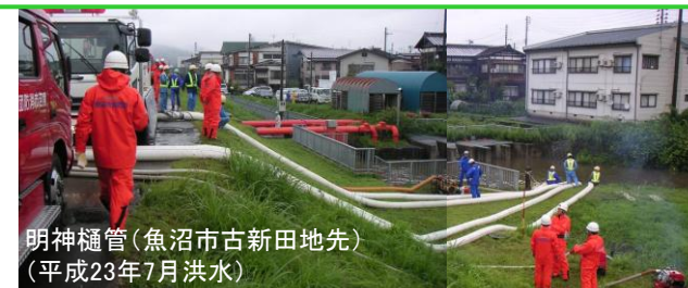
排水ポンプ車による内水排除状況(図2-4)
