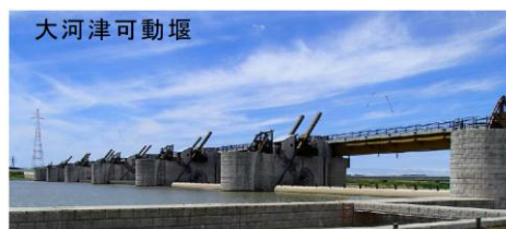
大河津分水路における堰の高さを抑えて景観へ配慮した事例(図2-8)
