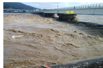
信濃川 旭橋:小千谷市 (10月13日13:40撮影)
