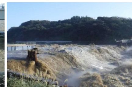
大河津分水路 第二床固:燕市 (10月13日16:06撮影)
