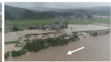
小千谷市岩沢地区における浸水被害状況
